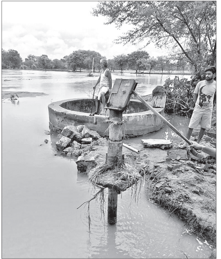
କୁରୁଲ ଗାଁରେ ସ୍ୱଳ୍ପ ଧାରା ପମ୍ପହାଉସ ଭାଙ୍ଗି ଦେବା ପରେ ନଳକୂପ ତଳୁ ମାଟି ଧୋଇଯାଇଛି ।
