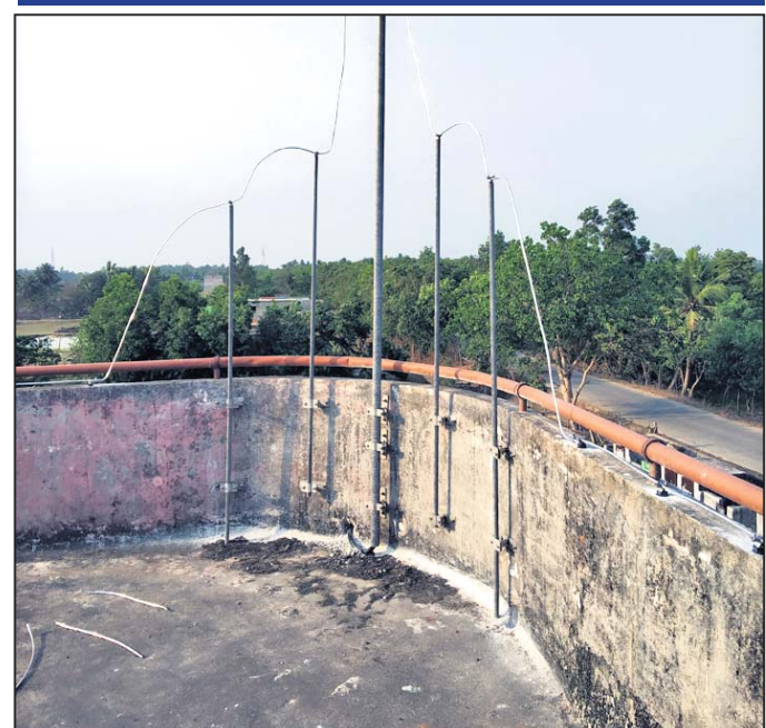
ବରକଳି ପଞ୍ଚାୟତ ଗ୍ଲାୟା ପ୍ରେମଚାନ୍ଦ ରଜବିଦ୍ୟାଳୟର ବହୁମୁଖୀ ବାତ୍ୟା ଆଶ୍ରୟ ସ୍ଥଳରେ ନିର୍ମିତ ବଜ୍ରପାତ ନିରୋଧ ଯନ୍ତ୍ର ।
