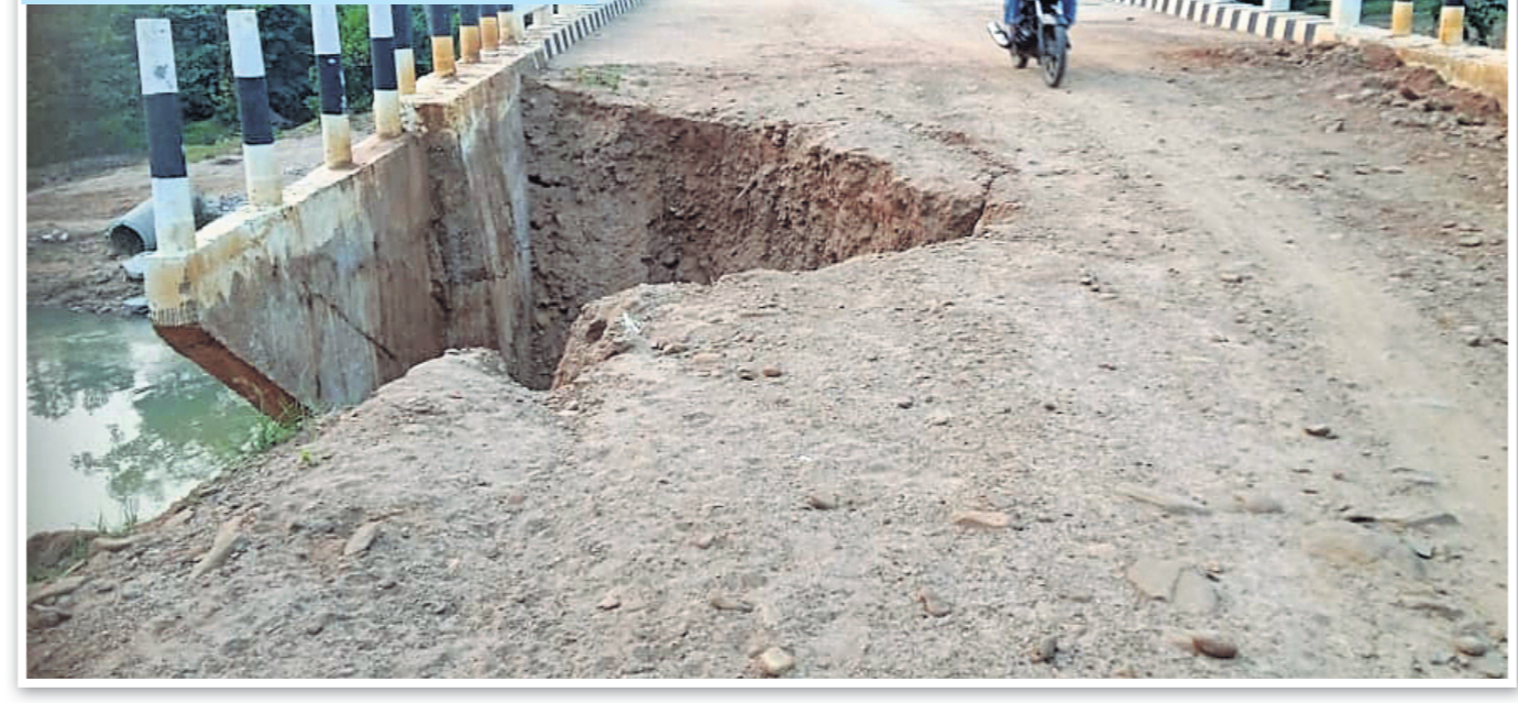
କନ୍ଧମାଳ ଜିଲ୍ଲା କୋଟଗଡ଼ ବ୍ଲକ୍ କୁଡ଼ାବାଳି ପଞ୍ଚାୟତ ରତ୍ନଗୁମା ନିକଟରେ ଗ୍ରାମ୍ୟ ନିର୍ମାଣ ବିଭାଗ (ଆର୍‌ଡି) ପକ୍ଷରୁ ନିର୍ମିତ ଗାଉଲଧୁଆ ନଦୀ ଉପରେ ହୋଇଥିବା ଏହି ପୋଲର ନିର୍ମାଣ ୩/୪ ମାତ୍ର ହେବ ସରିଛି। ପ୍ରଧାନମନ୍ତ୍ରୀ ଗ୍ରାମ ସଡ଼କ ଯୋଜନାରେ ନିର୍ମିତ ଏହି ପୋଲର ଗୋଟିଏ ପାର୍ଶ୍ୱ ସଂଯୋଗ ରାସ୍ତା ଧୋଇଯାଇଛି।
