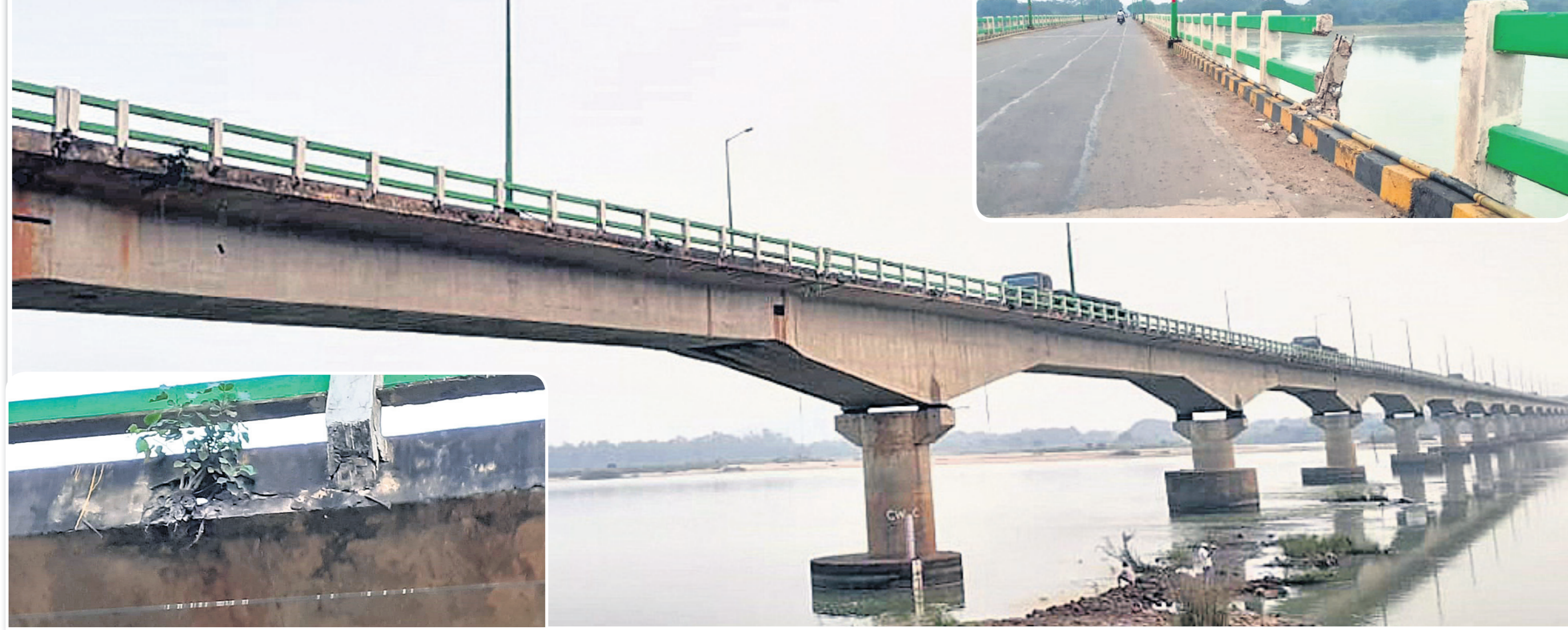
ଡେକାନାନ୍-କାମାକ୍ଷାନଗର ରାସ୍ତାର ରୋଡ୍‌ସିଆ ଓ କମଗରା ମଧ୍ୟରେ ପ୍ରବାହିତ ବ୍ରାହ୍ମଣୀ ନଦୀ ଉପରେ ପୂର୍ବ ବିଭାଗ ପକ୍ଷରୁ ୧୯୯୩ରେ ନିର୍ମାଣ କରାଯାଇଥିଲା ସାରଙ୍ଗଧର ସେତୁ। ରକ୍ଷଣାବେକ୍ଷଣ ଅଭାବରୁ ଏହି ବ୍ରିଜ୍ ଏବେ ବିପଦସଙ୍କୁଳ ହୋଇପଡ଼ିଛି। ବିଭିନ୍ନ ସ୍ଥାନରେ ସୁରକ୍ଷା ବାଡ଼ ଭାଙ୍ଗି ଯାଇଥିବାବେଳେ ବର, ଅଶୁଷ୍କ ଗଛ ଭଳି ଫାଟ ହୋଇଛି।
