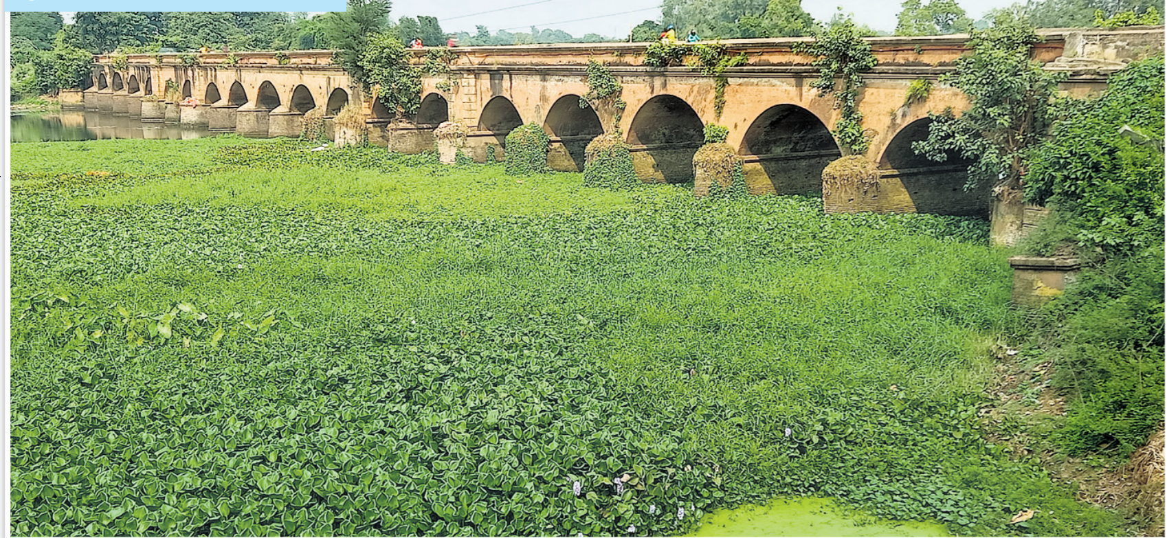
ବାଲେଶ୍ୱର ପୌରାଞ୍ଚଳର ୩୧ନଂ. ଖାଡ଼ି ସ୍ଥିତ ଅରବିନ୍ଦନୀ ନିକଟସ୍ଥ ନୁଣିଆଯୋଡ଼ି ପୋଲ ହରିପୁର ଛକଠାରୁ ମୁକ୍ତିଦ୍ୱାର ପର୍ଯ୍ୟନ୍ତ ଲମ୍ବିଛି। ବ୍ରିଜ୍ ଅନଳକୁ ତିଆରି ହୋଇଥିବା ଏହି ପୋଲର ଉଭୟ ପାର୍ଶ୍ୱରେ ଗଛ ଭଳିବା ସହ ଫାଟ ସୃଷ୍ଟି ହୋଇଛି। ବିପଦ ସଙ୍କୁଳ ଅବସ୍ଥାରେ ପ୍ରତିଦିନ ହଜାର ହଜାର ଲୋକ ତଥା ଭାରିଯାନ ଏହି ପୋଲ ଦେଇ ଯା' ଆସ କରୁଛନ୍ତି।
