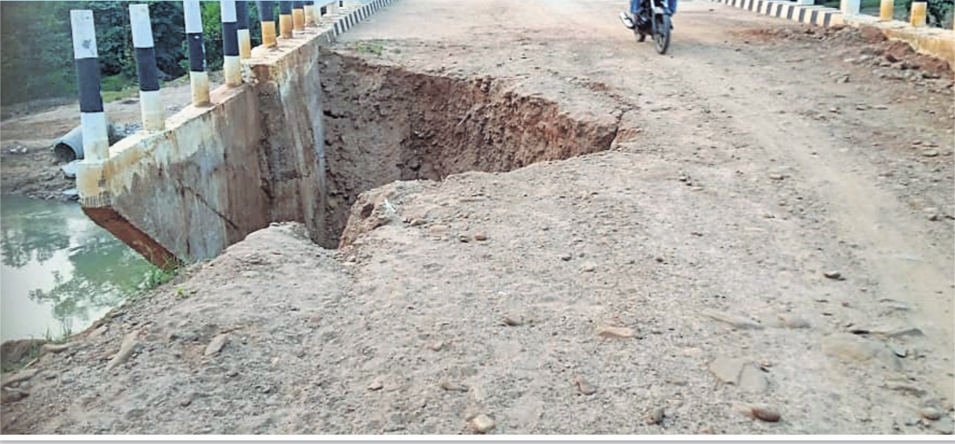
କନ୍ଧମାଳ ଜିଲ୍ଲା କୋଟଗଡ଼ ବ୍ଲକ୍ କୁଡ଼ାବାଳି ପଞ୍ଚାୟତ ରତ୍ନଗୁମା ନିକଟରେ ଗ୍ରାମ୍ୟ ନିର୍ମାଣ ବିଭାଗ (ଆର୍ଡି) ପକ୍ଷରୁ ନିର୍ମିତ ଚାଉଳଧୁଆ ନଦୀ ଉପରେ ହୋଇଥିବା ଏହି ପୋଲର ନିର୍ମାଣ ୩/୪ ମାସ ହେବ ସରିଛି। ପ୍ରଧାନମନ୍ତ୍ରୀ ଗ୍ରାମ ସଡ଼କ ଯୋଜନାରେ ନିର୍ମିତ ଏହି ପୋଲର ଗୋଟିଏ ପାର୍ଶ୍ୱ ସଂଯୋଗ ରାସ୍ତା ଧୋଇଯାଇଛି।
